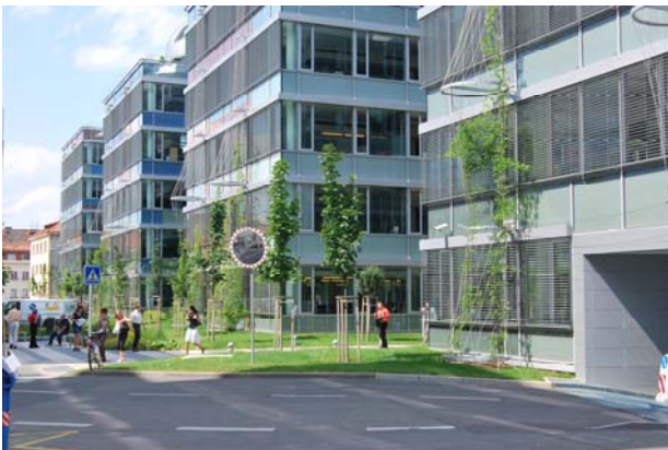
Bild 2: Die Konzernzentrale der grössten Versicherungsgesellschaft Tschechiens kann dank vernetzter Automation aller Gewerke mittels KNX eine um 60 Prozent verbesserte Energiebilanz vorweisen.
