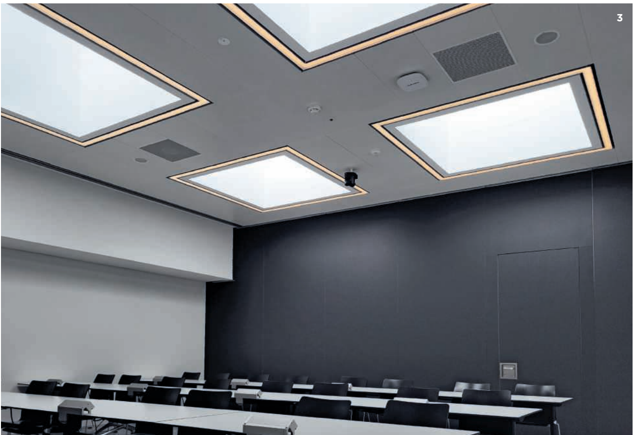
1 Die Doppelturnhalle bietet ideale Trainingsbedingungen für das Kunst- und Geräteturnen. Dazu gehört auch die optimale und energieeffiziente Ausleuchtung. 2 Ein Orientierungslicht begleitet die Nutzenden sicher und energieeffizient durchs Gebäude. 3 Im Schulungsraum im Untergeschoss lassen die Oberlichter Tageslicht herein.
